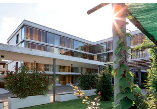
Das Alterszentrum Alenia verfügt bald über vier Häuser. Hier der Neubau an der Nussbaumallee 2.
